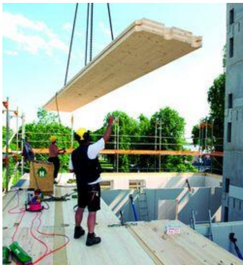
Montage von Brettsperrholz-Deckenelementen vor Ort beim achtgeschossigen Wohnungsbau in Bad Aibling, 2011. (Foto: Huber & Sohn GmbH & Co. KG)
